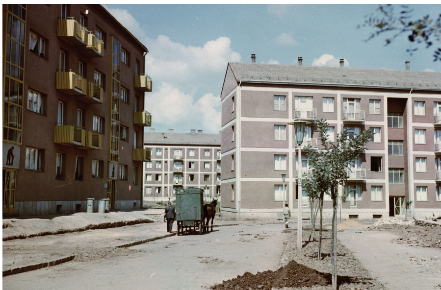
1. kép: Épülő utak – kezdetleges közlekedési lehetőségek 58
