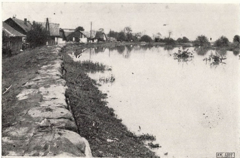
4. ábra. A Szamos-balparti töltés nyúlgátja Csengernél a hid és az országhatár között (1970. V. 15-én délután 80 cm-es apadás után) (Fotó: Varga J.)
