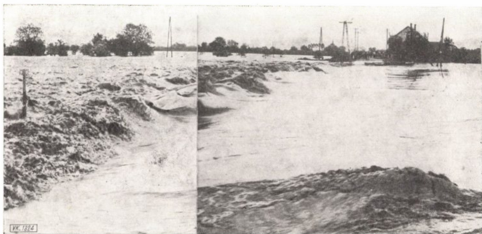
6. ábra A csengeri híd feljáró útján átbukó víz (1970. V. 15. du.) (Fotó: Varga J.) Рус. 6. Переливающаяся после мостового подъезда Ченгер вода (15-ого мая 1970 года) Fig. 6. Overtopping of the approach of the Csenger bridge (p. m., the 15th May, 1970) Abb. 6. Über dem Aufstiegsweg der Brücke Csenger überfallendes Wasser (am 15. Mai 1970, nachmittags)
