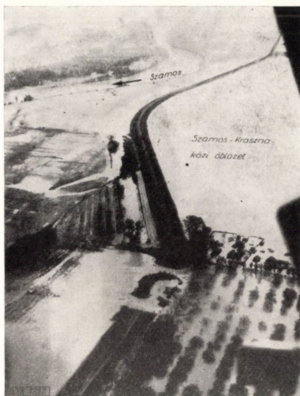
9. ábra. Az olcsvai töltés-megnyitás a Szamos-balpart 2700—2750 km szelvényben (1970. V. 27-én) (Fotó: Varga J.)
