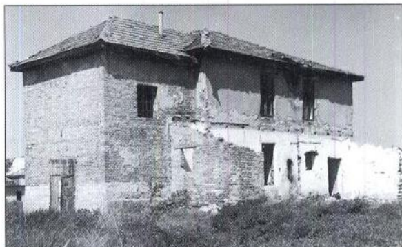
Az egykori haszid zsinagóga épülete
