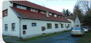
▲ Danos Lajos Általános Iskola, alsó tagozat
