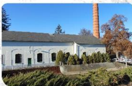
▲ Földvár László Szivattyútelep
