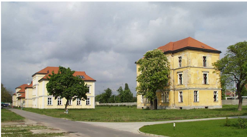
13. kép. A jobb oldalon a laktanya 3. számú épülete, a DE ÁJK későbbi széképülete a felújítás előtt. A kép bal oldalán a Közgazdaság- és Gazdaságtudomány Kar épületei (az egykori legénységi szállások) láthatók. 67
