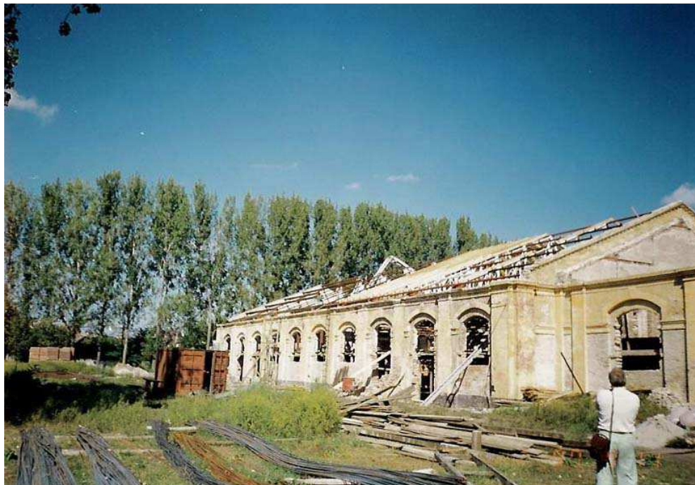
9. kép. A Lovarda a felújítás alatt. 53
