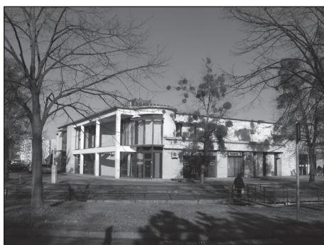
4.56 kép: Hélios üzletház déli homlokzata
