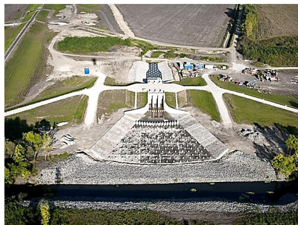
8. kép. A Szamos-Kraszna közti tározó leürítő műtárgya Nagydobosnál, madártávlatból (Forrás: Felső-Tisza-vidéki Vízügyi Történelmi Gyűjtemény adattára, FETIVIZIG, Nyíregyháza)
