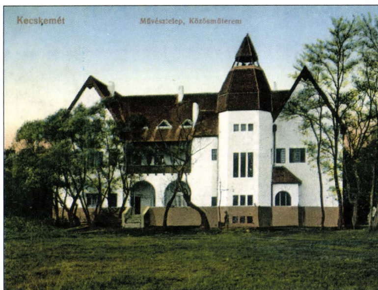
18. A Művésztelep műtermi épülete
